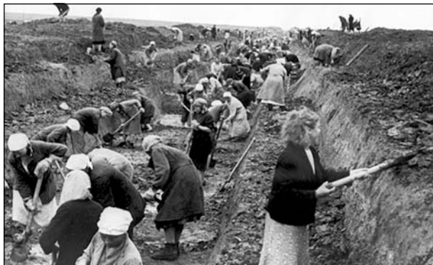
Строительство оборонительных сооружений
